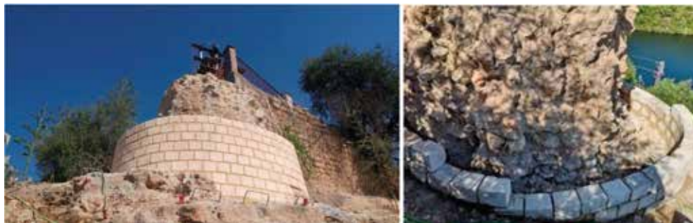
Torre sureste del recinto amurallado de Hornachuelos . Izquierda. Vista general de una reciente intervención (Foto: El Día de Córdoba). Derecha: detalle de la torre (Foto: Ayuntamiento de Hornachuelos).
