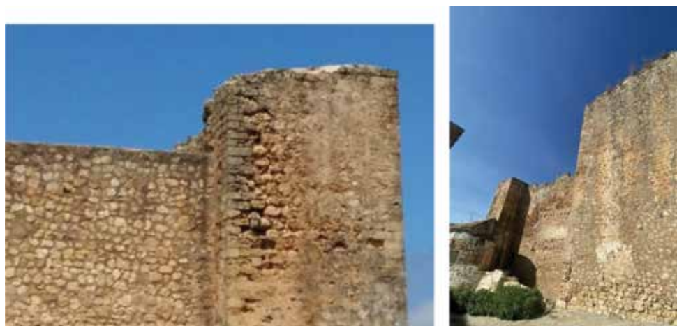
Torre noreste y tramo de la muralla recientemente restaurado (izquierda) y ángulo sureste del castillo de Hornachuelos, donde se fortaleció su sistema defensivo con la construcción de un antemuro en la segunda mitad del siglo XV (derecha).
