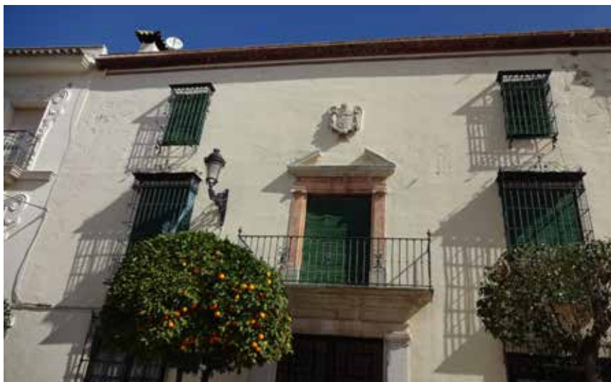
Fig. 2. Casa del Administrador de Medinaceli
