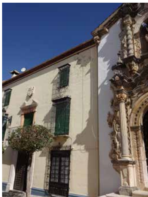
Casa del Administrador de Medinaceli
