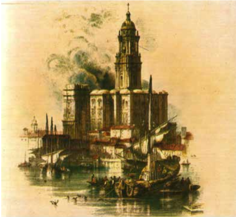
Ilustración 3.- Santa Iglesia Catedral de Málaga.
