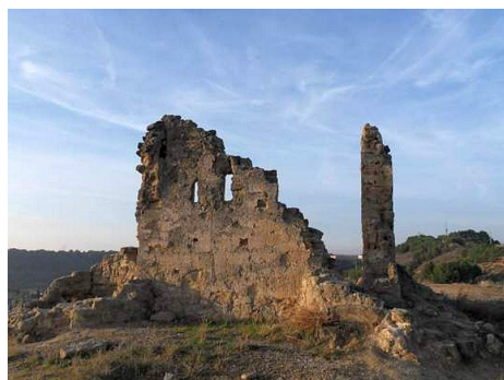
Restos de los muros y de la torre central
