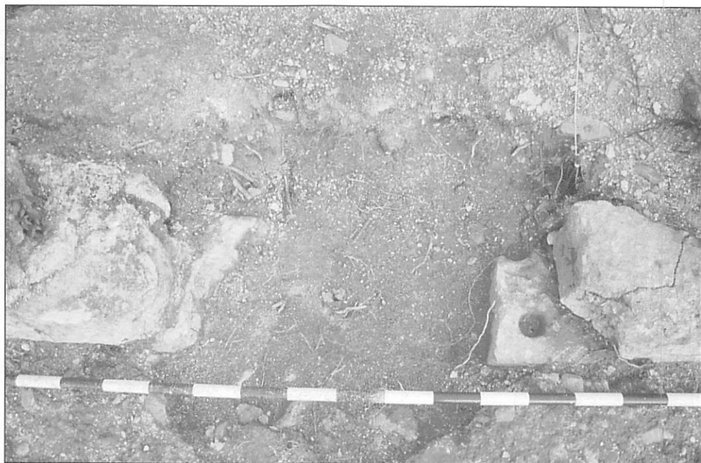
Foto 7. Vano de acceso a cámara de torre con labra circular para el encaje del gorrón.
