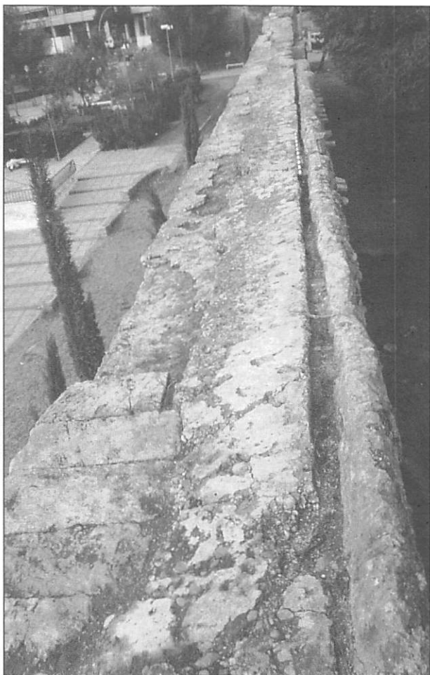
Foto 4. Pavimento del camino de ronda, constituido mediante alternancia de losas de arenisca y enfoscado de adamasa.
