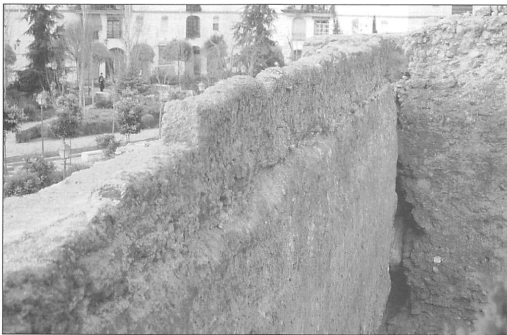
Foto 5. Restos de antepecho en el adarve sobre nivelación de ladrillo.
