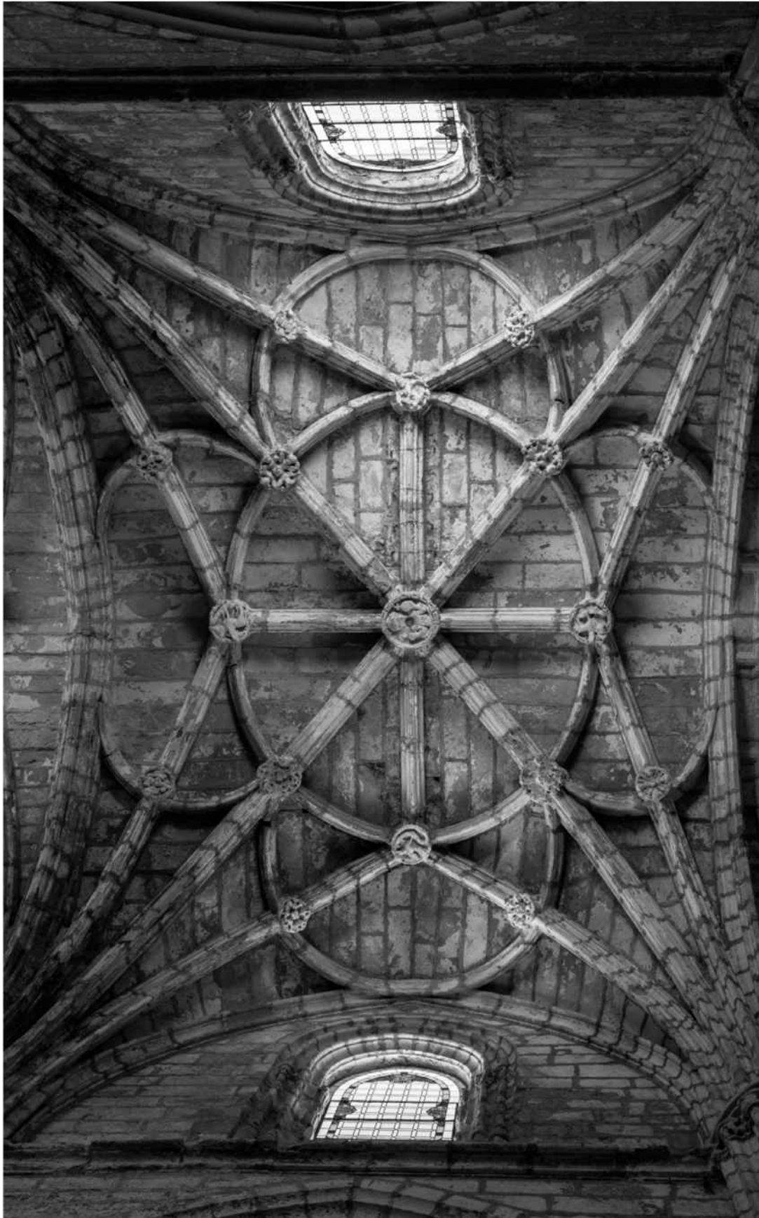
Iglesia de San Miguel, Morón de la Frontera (s. XV). Bóveda de crucería. Nave central. Oficina de Turismo de Morón de la Frontera.
