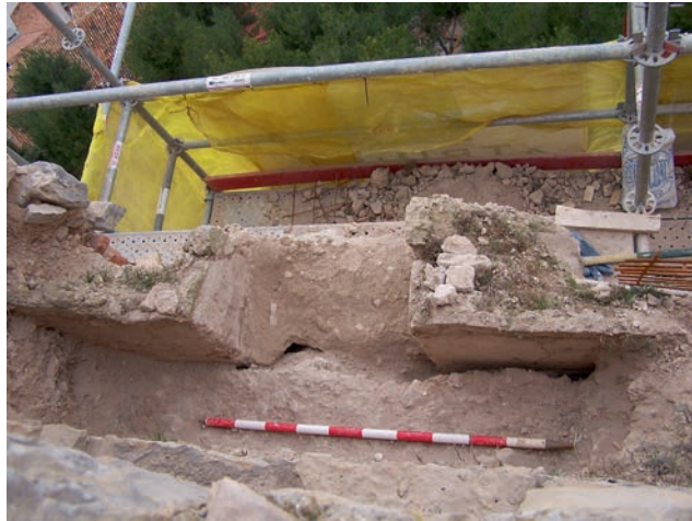
Fig. 1: Almenas encontradas en la masa del tapial del ala sur del recinto superior del Castillo
