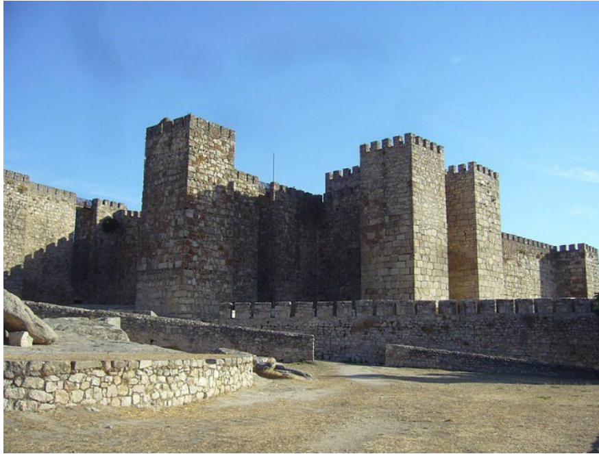
Fig. 5. Murallas de Trujillo
