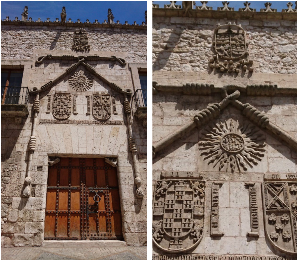
Fig. 4. Detalles de los escudos de la “Casa del Cordón”
