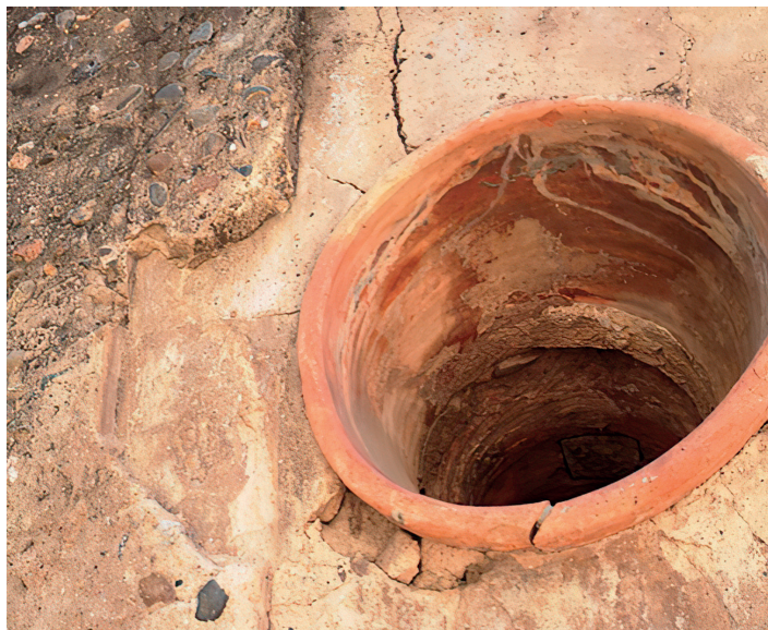
Cañería del Alcázar a su paso por la muralla del actual callejón del Agua. Independientemente de la cronología del mortero que hoy se aprecia, es interesante observar como predomina este en la parte más susceptible de intervención por parte de los cañeros, con el fin de facilitar las continuas reparaciones hidráulicas.
