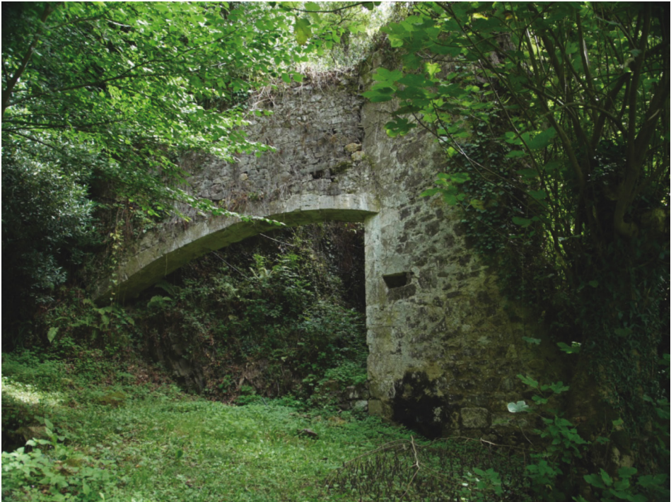
Ilustración 2. Apenas unos pocos restos quedan de la fábrica del monasterio de Belmonte. Fuente: fotografía del autor.
