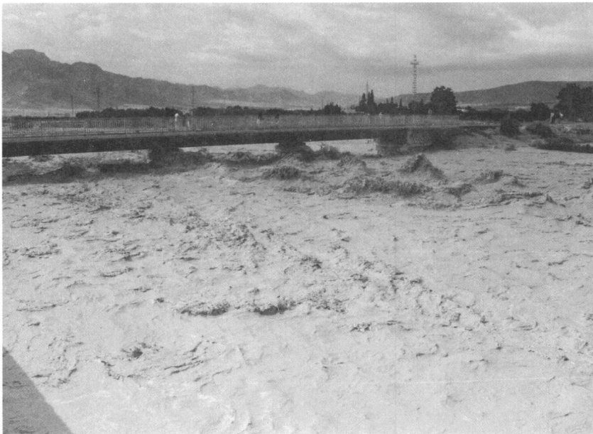
Foto n.º 1. Aspecto que ofrecía el puente del ferrocarril el día 26 de julio de 1986. Cuando ya se había iniciado el descenso del nivel del avenida.
