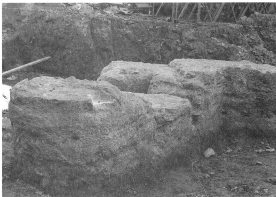
LÁMINA III.-1.) Detalle de la saetera 8 y hueco de sujeción del cadahalso. 2). Detalle del remate achaflanado del muro III.
