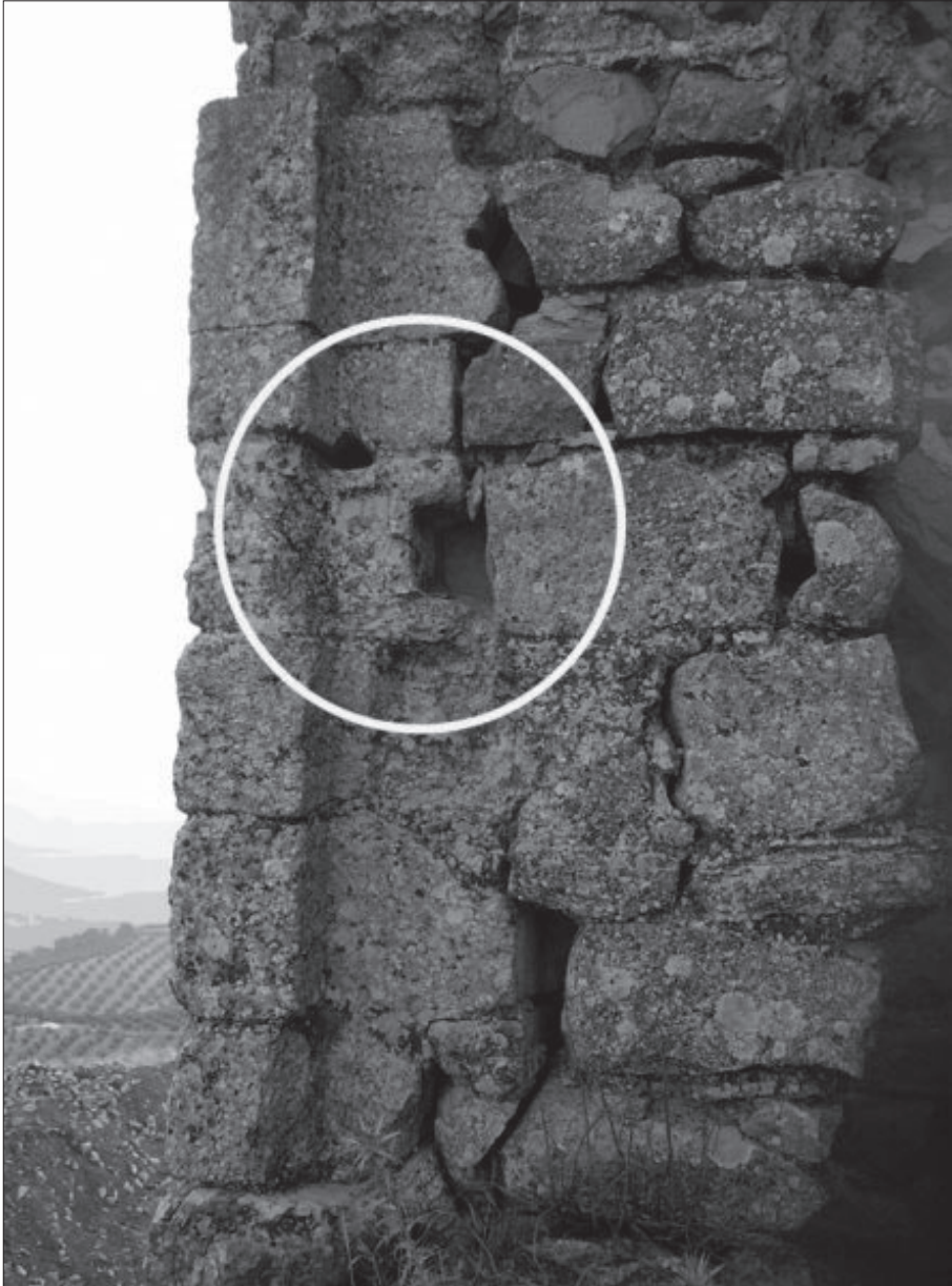
Figura 3. Seguridad en el acceso a la parte superior
