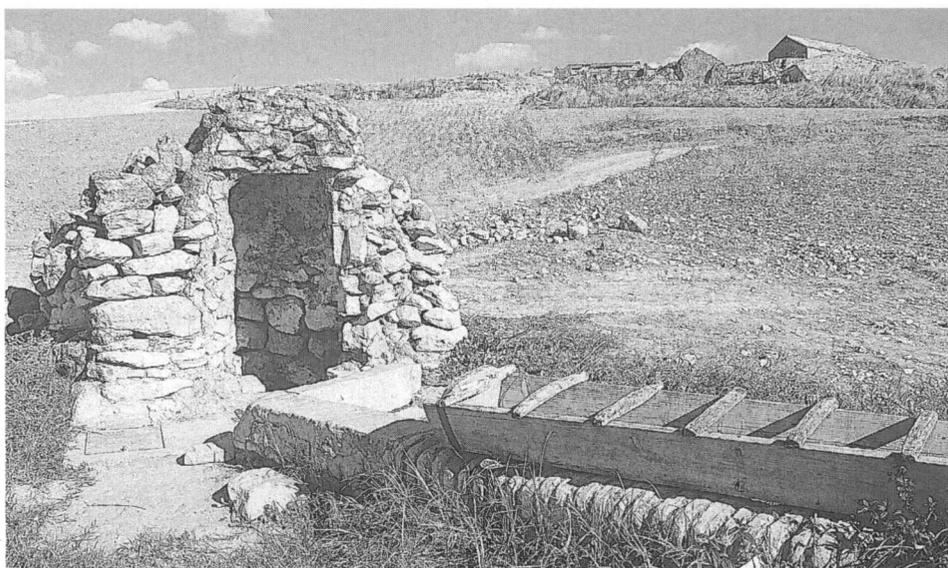
Fuente de Doña Mayor, junto al actual cortijo de la Fuentezuela. Se nos presenta como un pequeño depósito de planta circular cubierto mediante estructura abovedada, del que se extrae directamente el agua y cuyos remanentes dan origen al arroyo de Bernedo. Su disposición y estructura deben coincidir, básicamente, con la imagen que la fuente ha presentado desde finales de la Edad Media.
