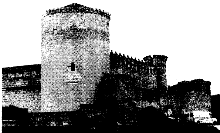
Figura 4. Torre del homenaje y antepuerta con el acceso a la fortaleza desde el sector nororiental (Víctor Muñoz Gómez).
