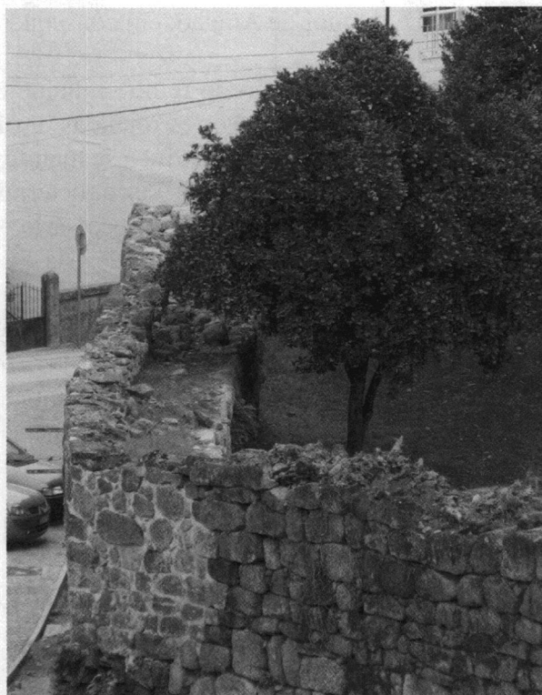
Fig. 11 – Troço de muralha, Rua Silva Gaio © Anísio Saraiva, 2009
