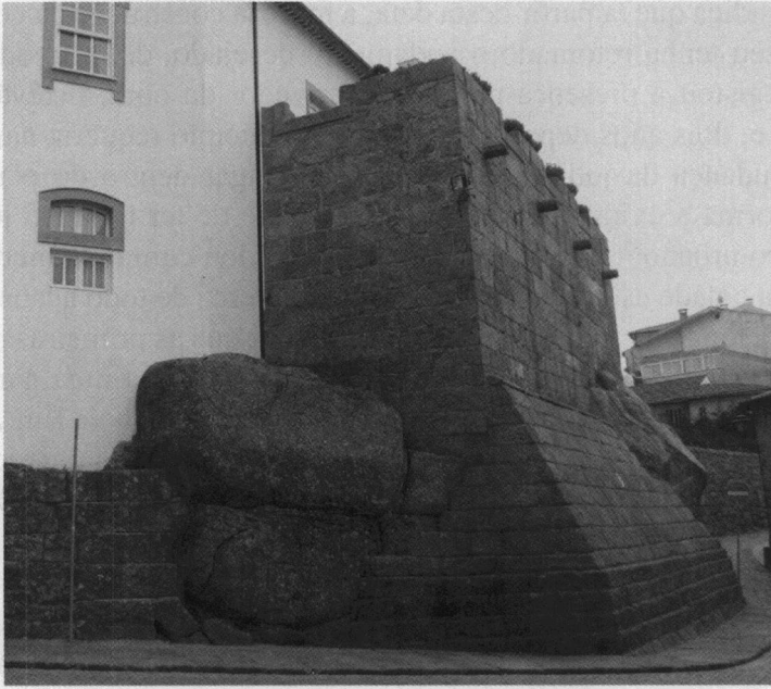
Fig. 12 – Troço de muralha, Soar © Anísio Saraiva, 2009
